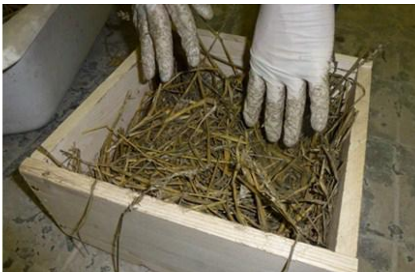
Obrázek 4: Plnění formy směsí slámy a cementového tmelu
