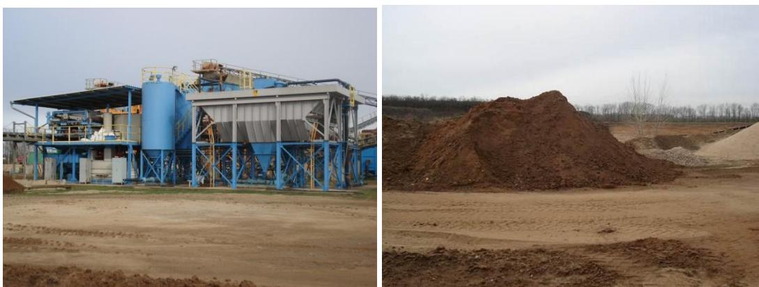
Obrázek 1: Kalolis pro odvodňování suspenze kalu a halda odvodněného kalu Ledece
