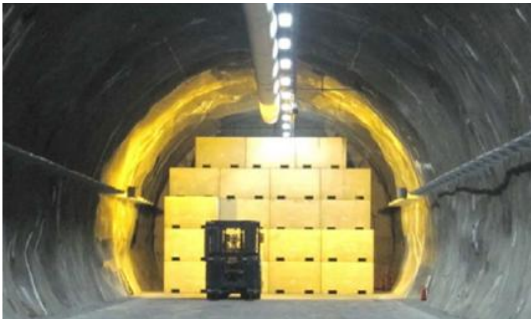
Obrázek 8: Ukládání betonových kontejnerů do úložiště Bátaapáti, PURAM, Maďarsko 23
