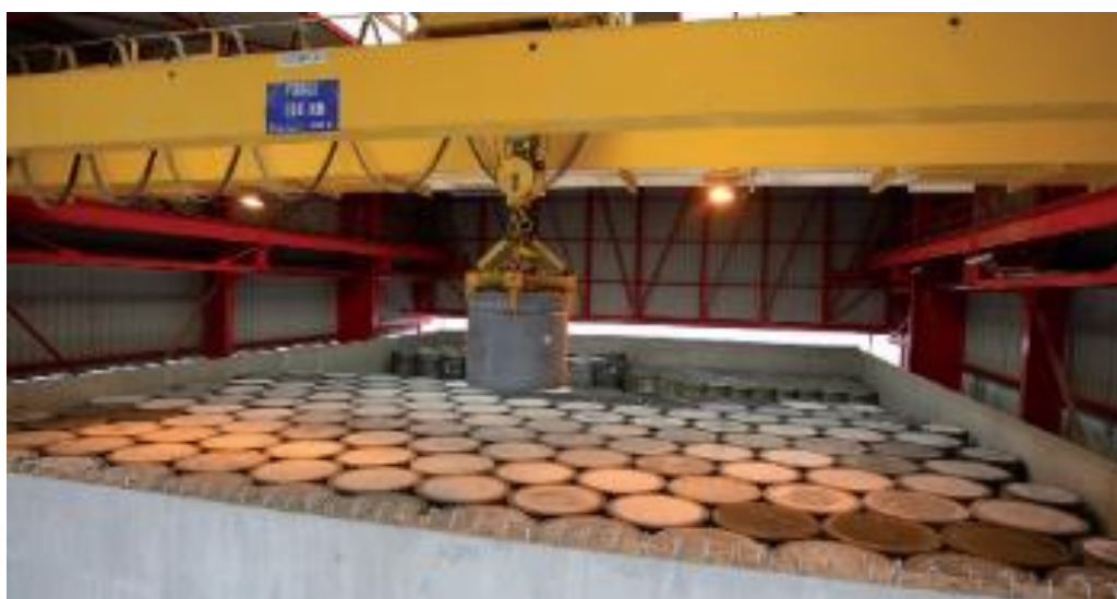
Obrázek 7: Pohled do zaplňované kobky 19 CSA v l'Aube, ANDRA, Francie
