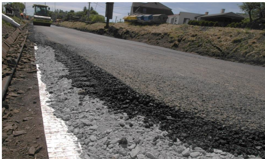
Obrázek 3: Celkový pohled na složení konstrukčních vrstev pražcového podloží (po zhutnění) ve zkušební úseku s horní vrstvou z asfaltové směsi s obsahem 70 % R-materiálu
