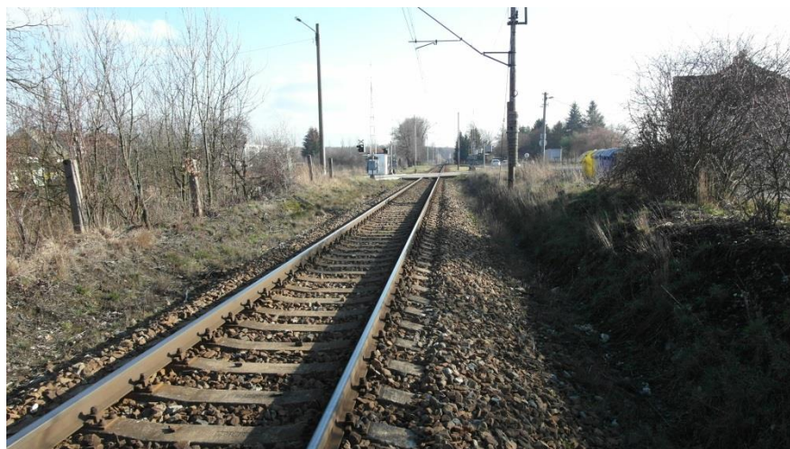
Obrázek 1: Pohled na zkušební úsek ve směru proti staničení
