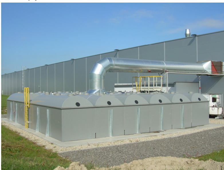
Obrázek 1: Provozní biofiltr o kapacitě 28 000 m 3 /hod
