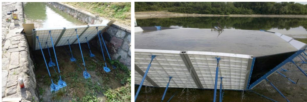
Obr. 10: Statická skúška pod hydrostatickým zaťažením v kanály a bazénová skúška
