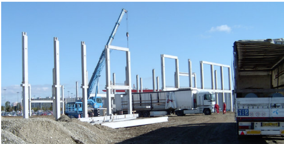
Obrázok 2: Montáž z dopravných prostriedkov, zdroj: autori
