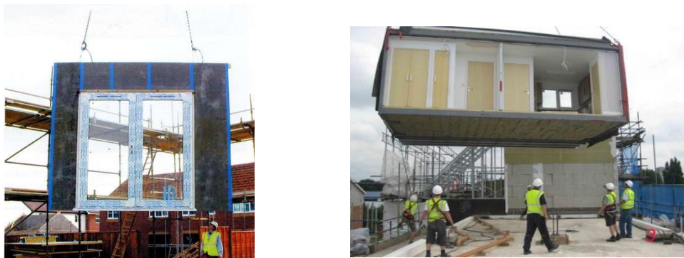
Obrázok 1: Montovanie prefabrikovaného panelu (1a) a modulu (1b) na stavbe zdroj: www.trada.co.uk/Timber frame
