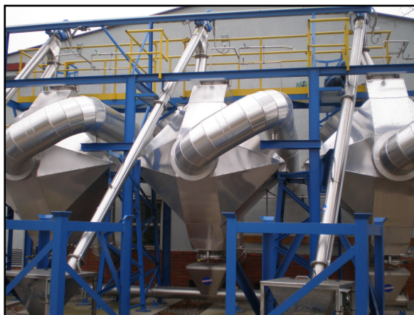
Obrázek 5, 6: Adsorpční jednotky na ÚČOV Praha- Bubeneč.
