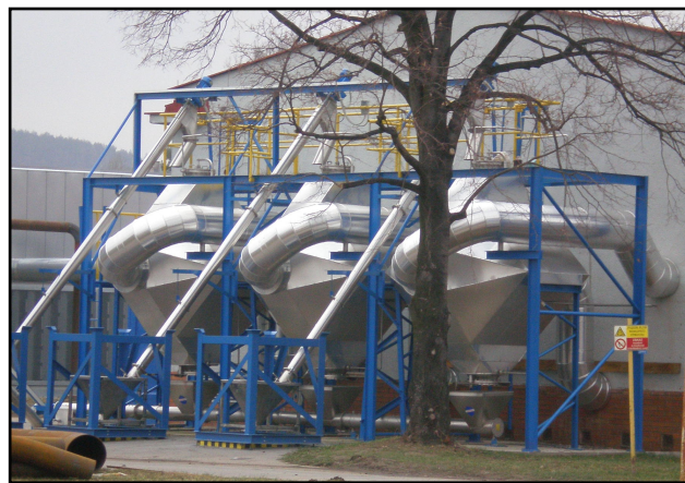
Obrázek 5, 6: Adsorpční jednotky na ÚČOV Praha- Bubeneč.
